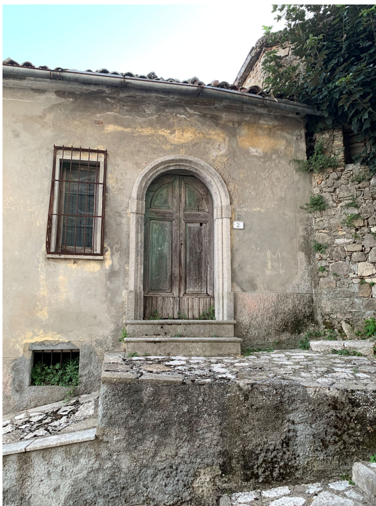
Foto n.3 – Ingresso Sub 2 da rampa Cuoco
