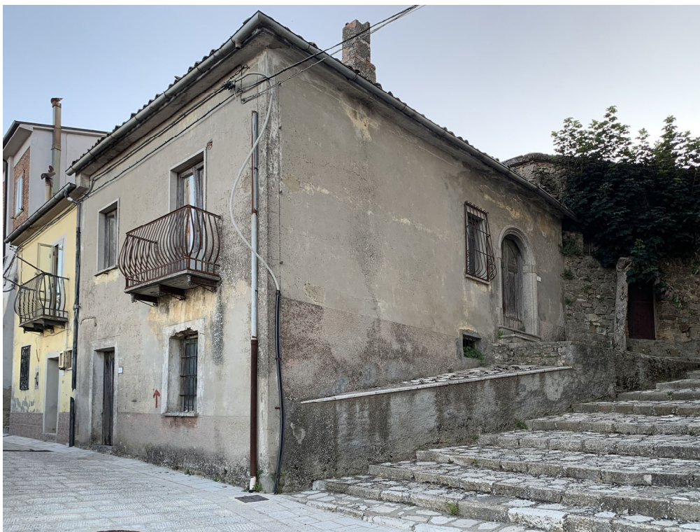
Foto n.1 - Vista immobile angolo via Colmeta - rampa Cuoco
